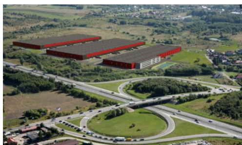
Rysunek 28. Przykład rozplanowania w terenie jednego z centrum logistycznego zbudowanego przez firmę 7R
