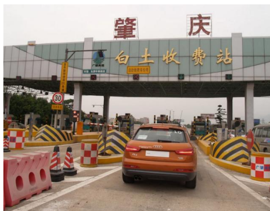
Rysunek 19. Miejsce kontrolne na przykładowej autostradzie w Chinach
